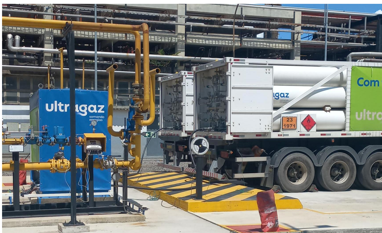
Figura 12 - Carretas Tipo 1 com 11 tubulões descarregando GNC em um cliente industrial
